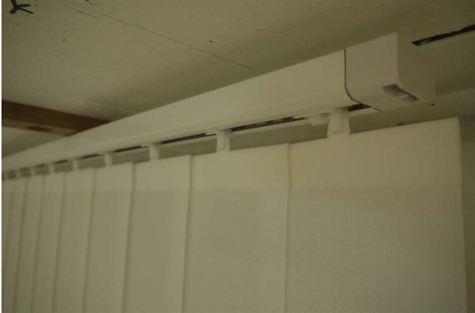
**Abbildung B.1.** Systemschiene mit eingehängten Lamellen
